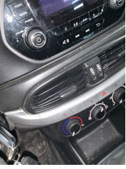
Kalorifer/Klima, Havalandırma ızgarası sabitlemesi > Kırılmış
