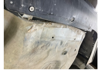
Arka bölüm, Bagaj havuzu > Hasarlı
