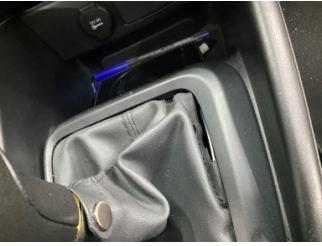
Şanzıman, Vites körüğü > Hasarlı
