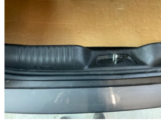
Döşemeler/Kapaklar, Döşemeler/Kapaklar > Deforme Olmuş
