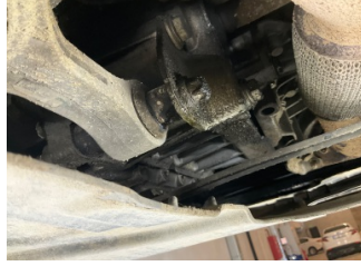
Şanzıman, Şanzıman > Yağ Kaçağı
