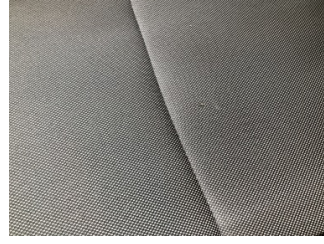
Döşemeler/Kapaklar, Döşemeler/Kapaklar > Yakıcı Madde Ile Zarar Görmüş
