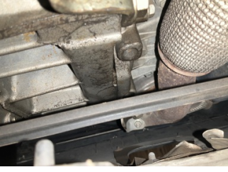
Şanzıman, Şanzıman > Yağ Kaçağı
