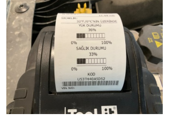
Elektrik donanımı/Pano, Akü > Test Sonucu
