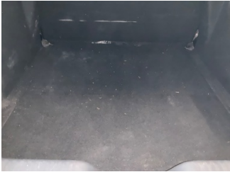
Döşemeler/Kapaklar, Döşemeler/Kapaklar > Kirlenmiş
