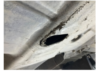
Motor, Alt muhafaza > Hasarlı
