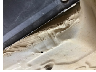
Arka bölüm, Bagaj havuzu > Hasarlı
