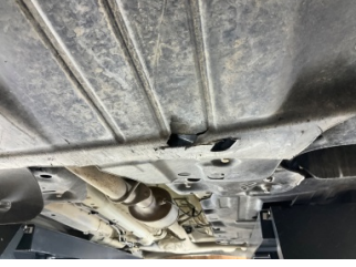
Motor, Alt muhafaza > Hasarlı
