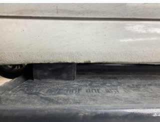
Marşbiyel, sol, Marşbiyel, sol > Boyası Atmış
