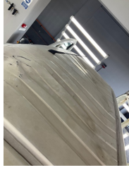
Tavan, Tavan > Hasarlı
