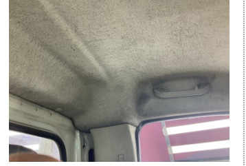
Döşemeler/Kapaklar, Tavan döşemesi > Kirlenmiş
