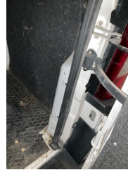
Arka bölüm, Bagaj kapağı fitili > Hasarlı
