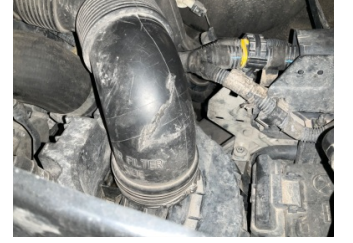
Motor, Hava filtresi kabı > Hasarlı
