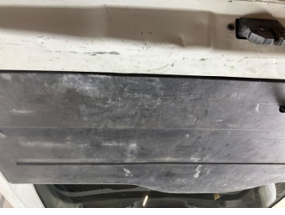
Döşemeler/Kapaklar, Döşemeler/Kapaklar > Hasarlı
