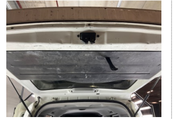
Döşemeler/Kapaklar, Döşemeler/Kapaklar > Deforme Olmuş
