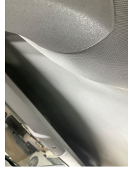
Döşemeler/Kapaklar, Tavan döşemesi > Deforme Olmuş
