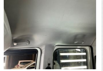
Döşemeler/Kapaklar, Tavan döşemesi > Deforme Olmuş
