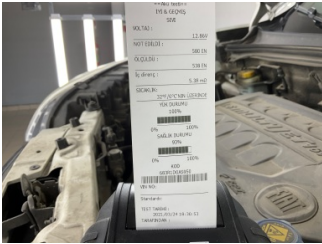
Elektrik donanımı/Pano, Akü > Test Sonucu
