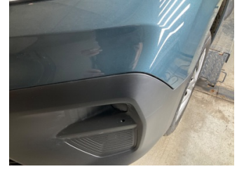
Tampon, ön, Ön tampon > Sabitlemesi Hatalı
