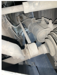
Ön aks, Denge çubuğu, bağlantı cubuğu sağ > Hasarlı
