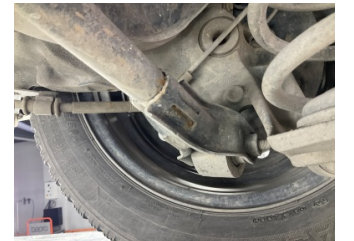
Arka aks, Arka aks transvers burçları > Deforme Olmuş
