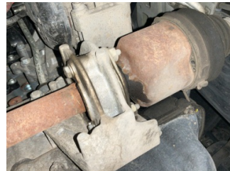
Ön aks, Aks mili, sağ > Yağ Kaçağı
