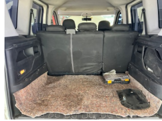
Döşemeler/Kapaklar, Döşemeler/Kapaklar > Deforme Olmuş
