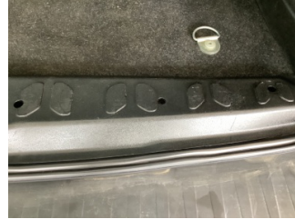
Döşemeler/Kapaklar, Yükleme eşiği kaplaması > Çizik
