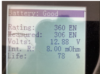
Elektrik donanımı/Pano, Akü > Test Sonucu
