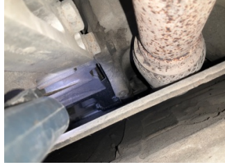
Şanzıman, Şanzıman > Yağ Kaçağı
