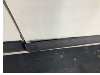
Kapı, sağ ön, Kapı bandı > Sabitlemesi Hatalı
