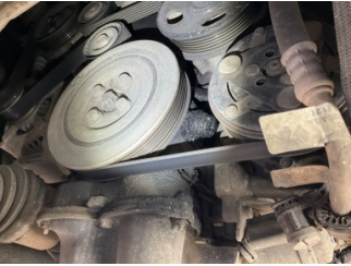
Motor, Motor > Yağ Kaçağı
