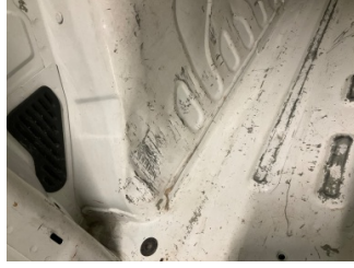
Arka bölüm, Bagaj havuzu > Hasarlı
