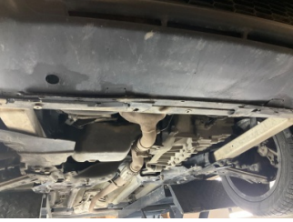
Tampon, ön, Tampon koruyucu orta > Hasarlı
