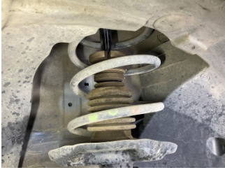
Ön aks, Amortisör körüğü, sol > Hasarlı
