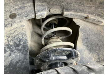
Ön aks, Amortisör körüğü, sağ > Hasarlı
