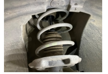
Ön aks, Amortisör körüğü, sol > Hasarlı
