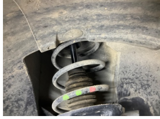
Ön aks, Amortisör körüğü, sağ > Hasarlı
