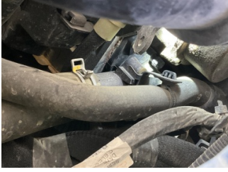
Motorsoğutması, Soğutma sıvısı > Sızdırıyor
