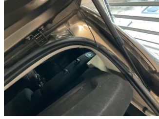
Döşemeler/Kapaklar, Pandizot > Hasarlı
