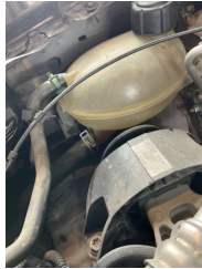
Motorsoğutması, Soğutma sıvısı > Eksik
