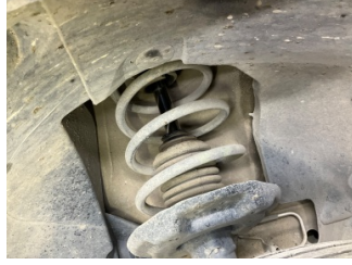
Ön aks, Amortisör körüğü, sağ > Hasarlı
