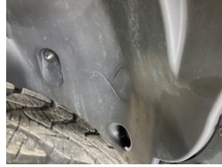
Çamurluk, sol, Davlumbaz > Kırılmış
