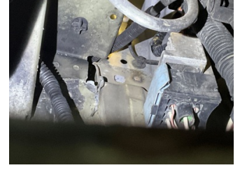
Kaporta, Sol Ön Şase > Hasarlı
