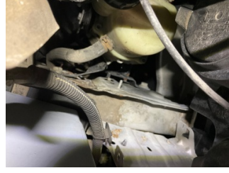
Kaporta, Sol Ön Şase > Hasarlı
