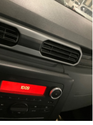
Kalorifer/Klima, Havalandırma ızgarası > Kırılmış
