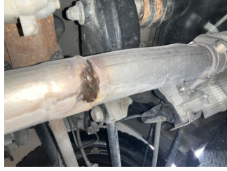
Egzoz sistemi, Arka boru > Çatlak
