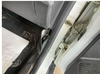
Döşemeler/Kapaklar, Döşemeler/Kapaklar > Sabitlemesi Hatalı
