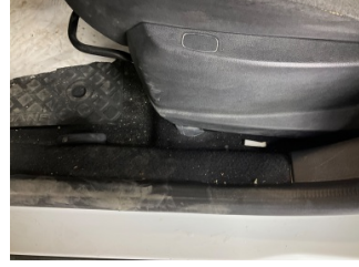
Döşemeler/Kapaklar, Döşemeler/Kapaklar > Yakıcı Madde Ile Zarar Görmüş
