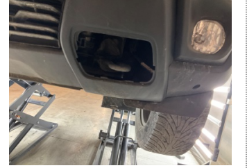
Tampon, ön, Çeki demir kapağı > Sökülmüş-Yok
