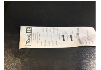
Elektrik donanımı/Pano, Akü > Test Sonucu
