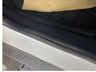
Kapı, sol ön, Kapı fitili > Hasarlı
