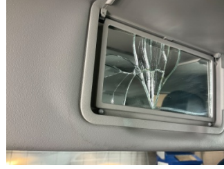
Döşemeler/Kapaklar, Güneşlik > Hasarlı
