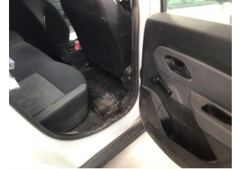
Döşemeler/Kapaklar, Döşemeler/Kapaklar > Kirlenmiş
