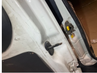
Bagaj kapağı/kapısı, Menteşe > Hasarlı
