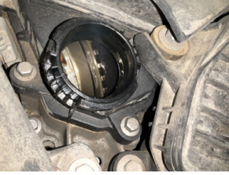
Motor, Triger kayışı > Çatlak
