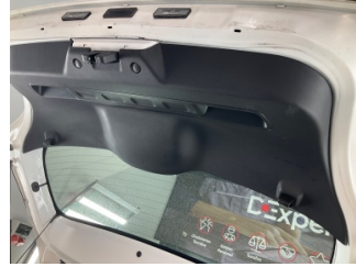
Döşemeler/Kapaklar, Döşemeler/Kapaklar > Çizik
