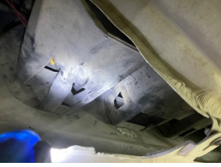
Tampon, arka, Bağlantı ayağı > Hasarlı
