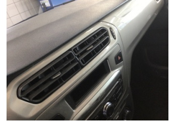
Kalorifer/Klima, Havalandırma ızgarası > Hasarlı
