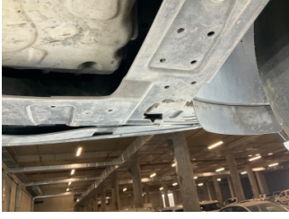
Motor, Alt muhafaza > Hasarlı
