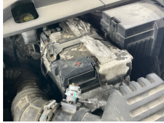
Elektrik donanımı/Pano, Akü > Deforme Olmuş
